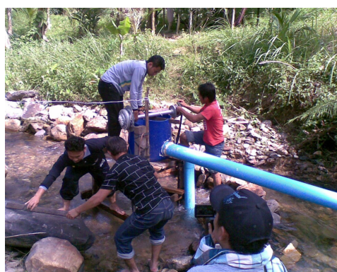
ภาพที่ 2 การติดตั้งและทดสอบระบบผลิตไฟฟ้าพลังงานน้ำขนาดเล็กอย่างง่าย
