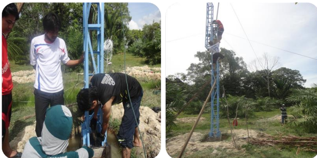
ภาพที่ 4.2 การติดตั้งโครงเสาทั้งหลม
