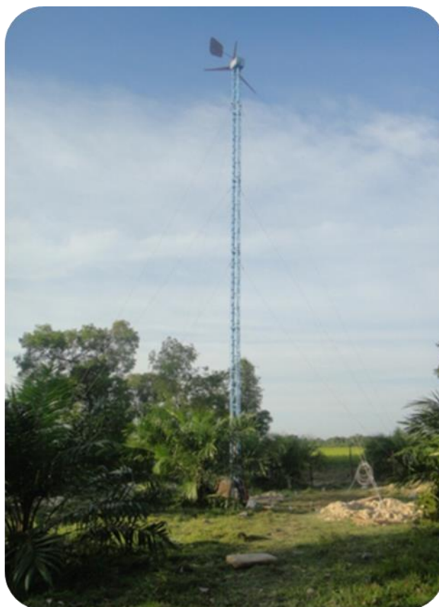
ภาพที่ 4.7 กังหันลมผลิตไฟฟ้าความเร็วรอบต่ำอย่างง่าย
