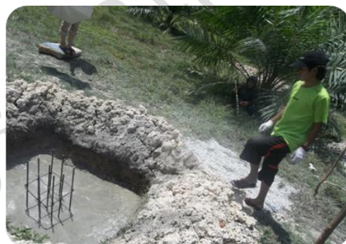
ภาพที่ 3.7 ฐานติดตั้งเสาและลวดสลิงยึดเสากึ่งหั่นกลม
