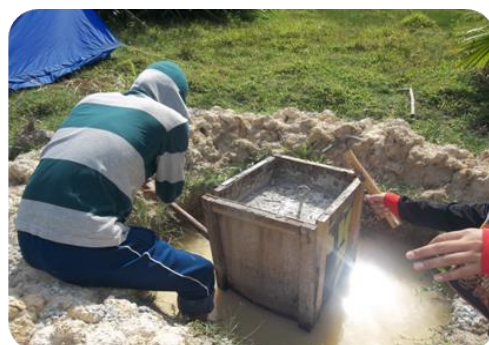
ภาพที่ 3.8 การติดตั้งเสาและสมอบกเพื่อยึดลวดสลิงเข้ากับเสากึ่งหั่นกลม
