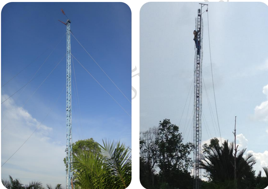
ภาพที่ 3.10 โครงเสากิ่งหันลมที่ติดตั้งบนฐานแล้วยึดด้วยลวดสลิง
