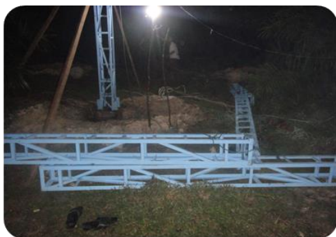
ภาพที่ 3.6 เสากึ่งหั่นกลมขนาดความกว้างด้านละ 26 cm เชื่อมต่อเป็นโครงจากเหล็กฉาก
