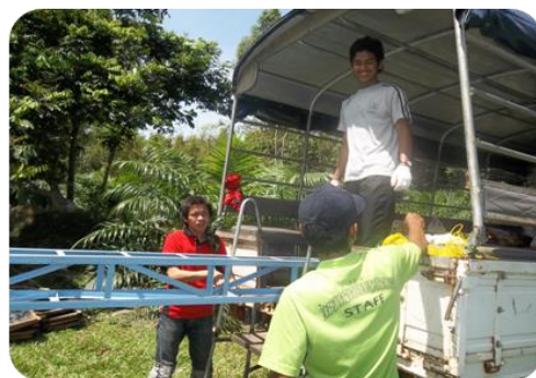
ภาพที่ 3.6 เสากึ่งหั่นกลมขนาดความกว้างด้านละ 26 cm เชื่อมต่อเป็นโครงจากเหล็กฉาก
