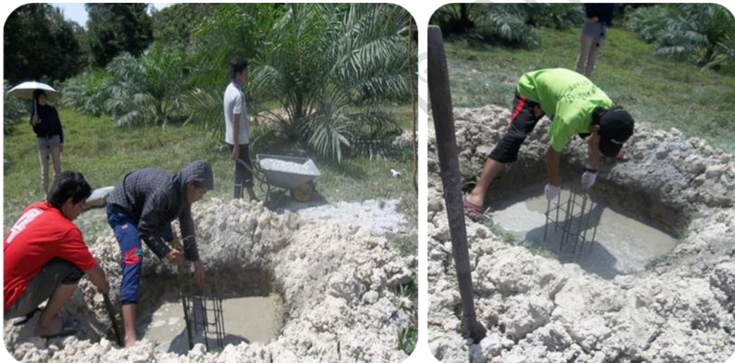
ภาพที่ 4.1 การสร้างฐานต่อม่อเสากังหันลม
