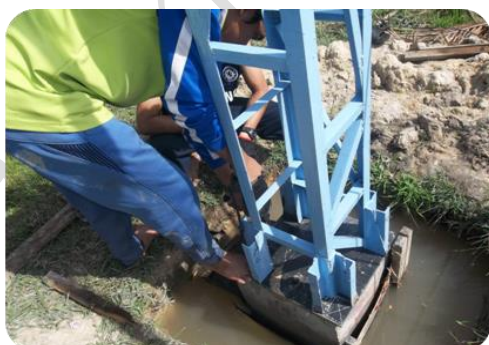
ภาพที่ 3.8 การติดตั้งเสาและสมอบกเพื่อยึดลวดสลิงเข้ากับเสากึ่งหั่นกลม
