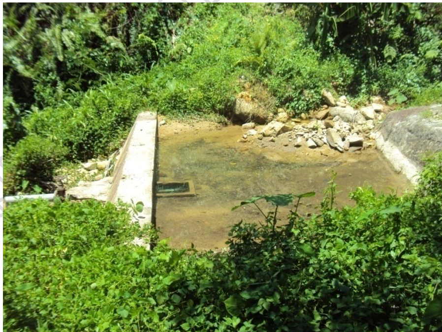
ภาพที่ 20 แสดงภาพฝายทดน้ำ
