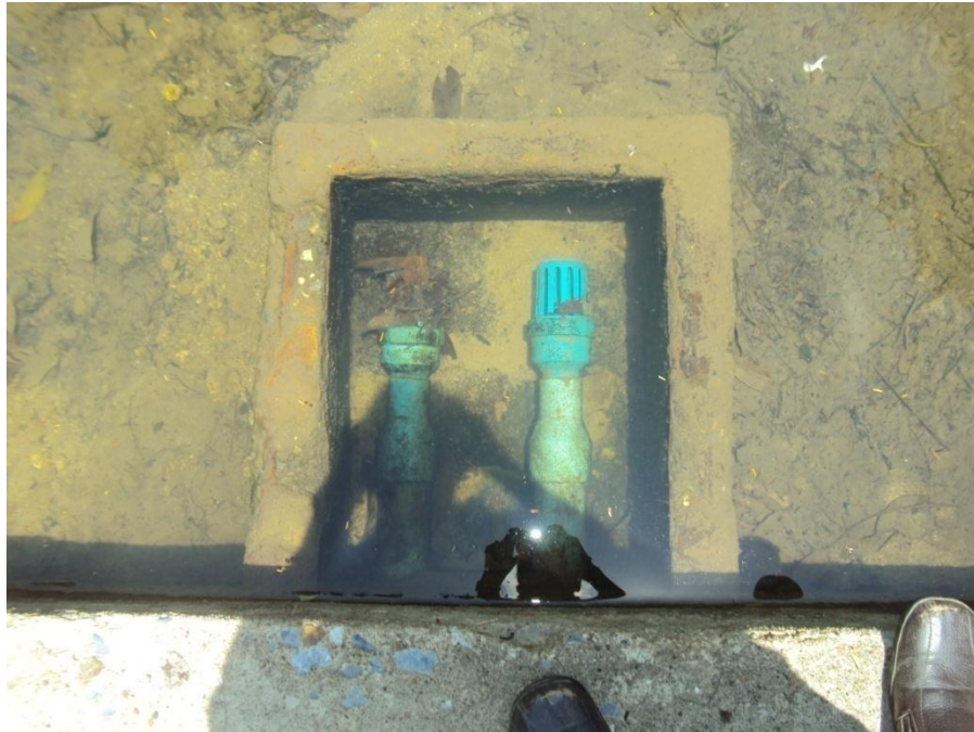
ภาพที่ 21 แสดงภาพท่อส่งน้ำเหนือฝายทดน้ำ มีจำนวน 2 ท่อ ลักษณะเป็นท่อพี.วี.ซี. ขนาด 3 นิ้ว ปากท่อมีฝาครอบ 1 ท่อ ส่วนอีกท่อ ไม่มีฝาครอบ
