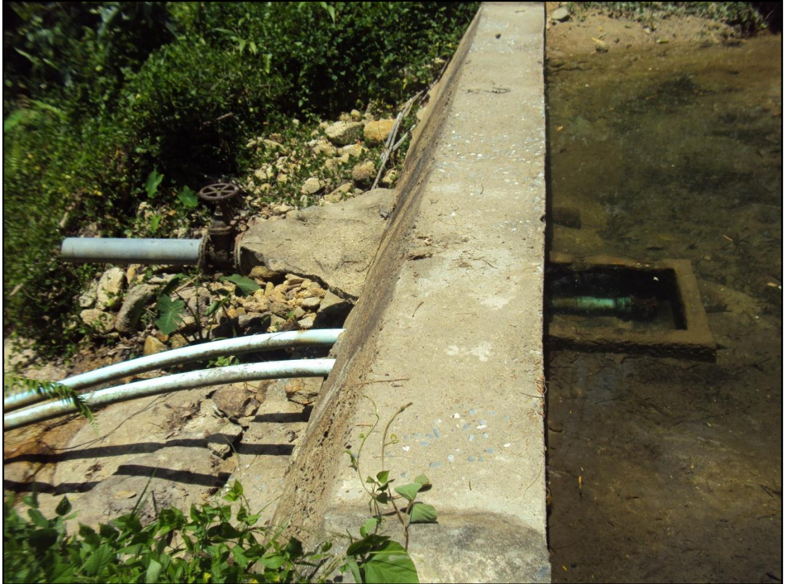
ภาพที่ 5 แสดงรูปถ่ายฝ่ายทดน้ำที่ใช้ผลิตน้ำประปาภูเขาในตำบลกาหลง อำเภอศรีสาคร จังหวัดนราธิวาส
