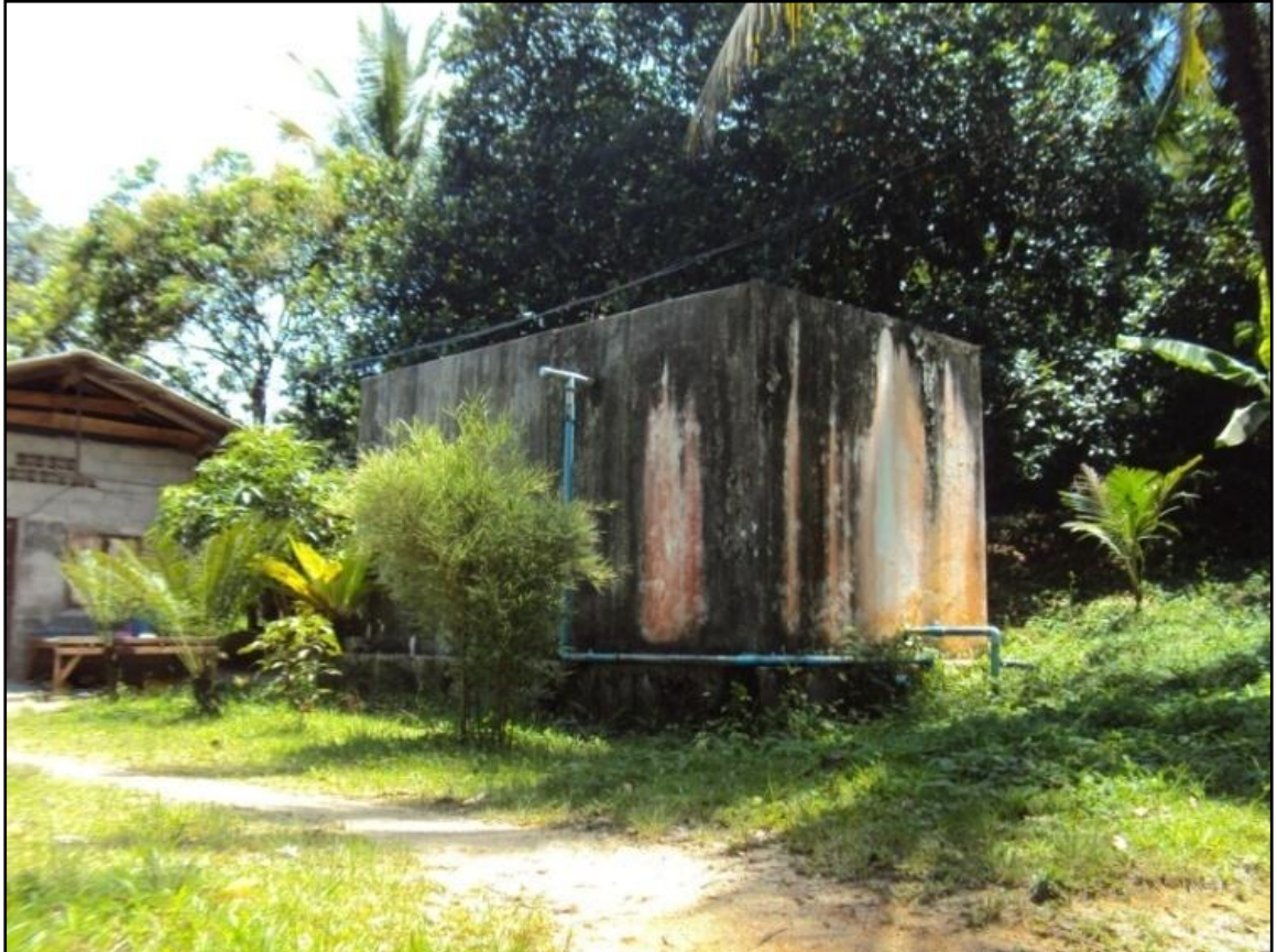
ภาพที่ 6 แสดงรูปถ่ายบ่อพักน้ำที่ใช้ในการผลิตน้ำประปาภูเขาในตำบลกาหลง อำเภอสรีสาคร จังหวัดนราธิวาส
