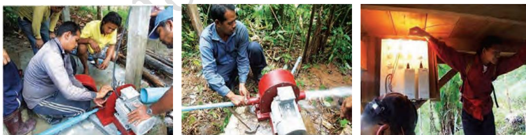
ภาพที่ 2.7 การติดตั้งและขยายผลระบบกังหันน้ำผลิตไฟฟ้าขนาดเล็กโดยกลุ่มกังหันน้ำคีรีวง (ที่มา : อุสาห, 2555)
