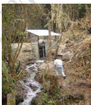
ภาพที่ 2.5 กังหันน้ำแบบคอยาวขนาด 200 W สำหรับครัวเรือนที่ติดตั้งในประเทศเอกวาดอร์ (ที่มา : John et al., 2005)
