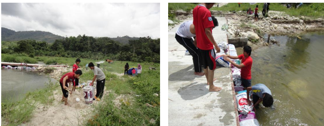
ภาพที่ 3.2 การกันสายน้ำให้ได้ระดับความสูงประมาณ 85.0 cm ด้วยกระสอบบรรจุทราย
