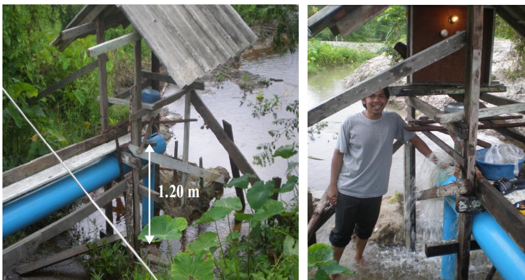
ภาพที่ 2.9 การติดตั้งและทดสอบระบบผลิตไฟฟ้าพลังงานน้ำขนาดเล็กที่ได้ออกแบบและสร้างขึ้น ณ มูลนิธิสุข-แก้ว แก้วแดง (ที่มา : อีลีหัยะ และคณะ, 2552)
