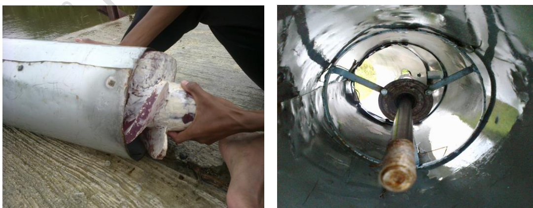
ภาพที่ 4.5 การติดตั้งแกนและกั้นน้ำในท่อส่งน้ำ
