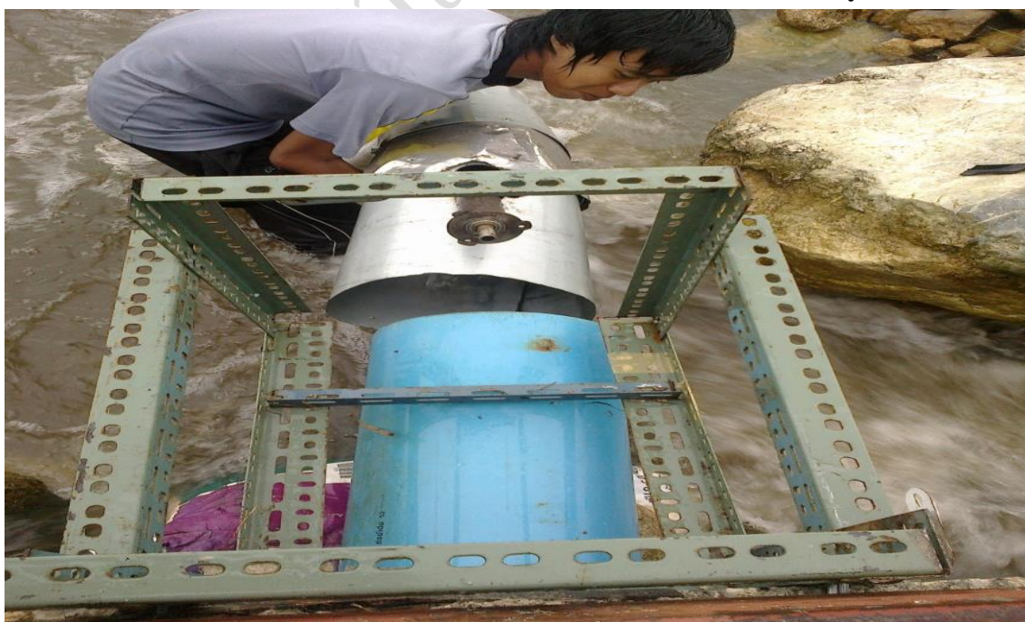
ภาพที่ ก-21 การติดตั้งโครงเหล็กยึดมอเตอร์กำเนิดไฟฟ้าบนท่อพีวีซีขนาดเส้นผ่านศูนย์กลาง 10 นิ้ว
