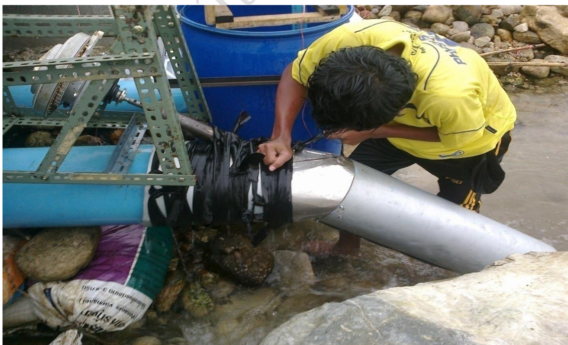
ภาพที่ ก-23 การติดตั้งมอเตอร์ให้เข้ากับแกนเหล็ก
