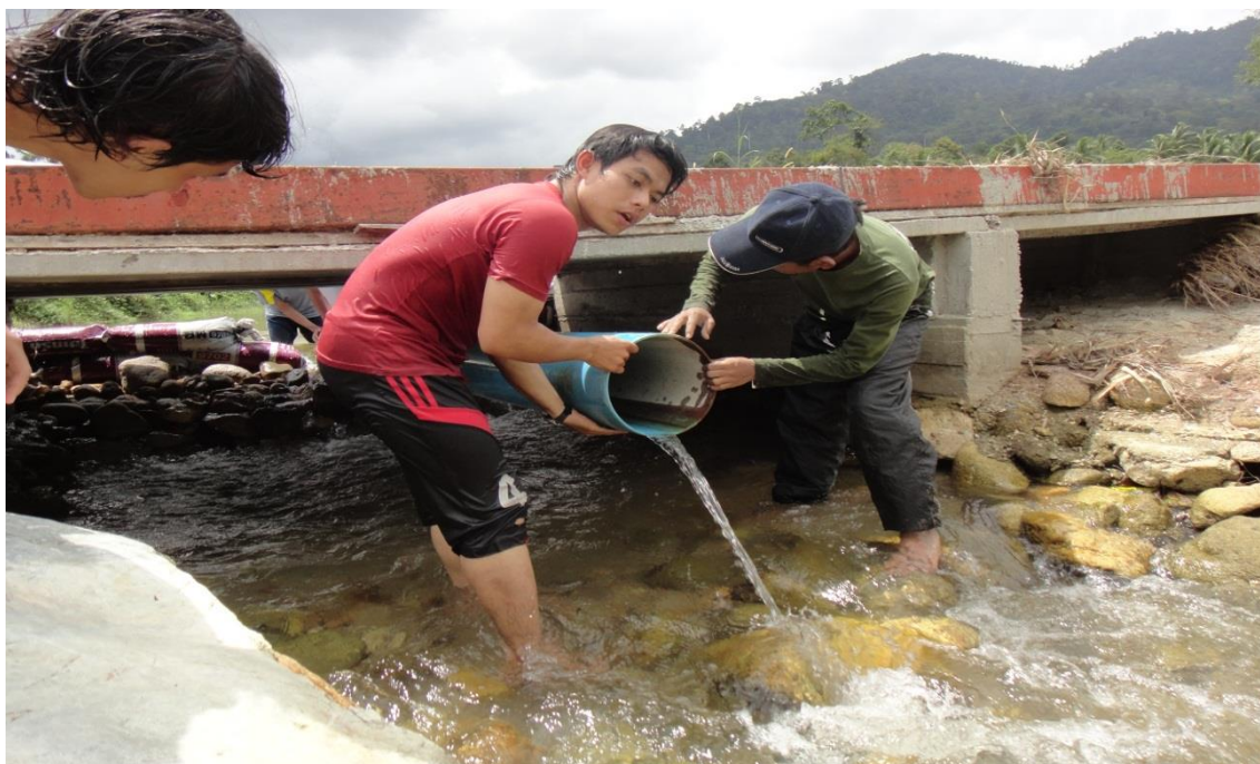
ภาพที่ ก-16 การวางท่อพีวีซี (PVC) ขนาด 10 นิ้ว เพื่อส่งน้ำเข้าสู่ชุดกำเนิดไฟฟ้าพลังงานน้ำอย่างง่าย
