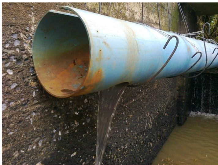
ภาพที่ 3.5 การเจาะช่องสำหรับแกนและช่องใบพัดที่ปลายท่อพีวีซีขนาด 25.4 cm
