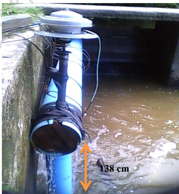
ภาพที่ 3.6 การติดตั้งเครื่องกำเนิดไฟฟ้ากับท่อพีวีซี
